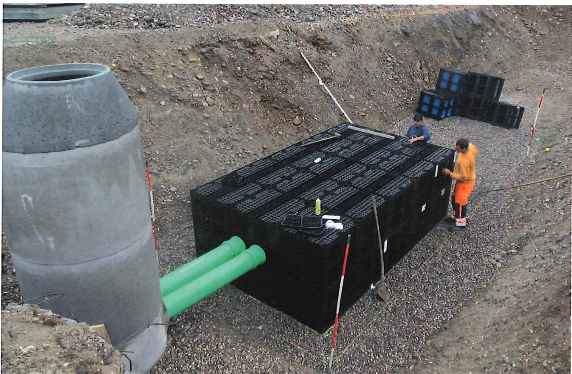
Abb. 1 Einbau der Speicherelemente der Firma Rehau (Rausikko-Boxen)
